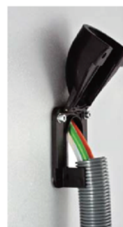
2. Insert conduit with cables
